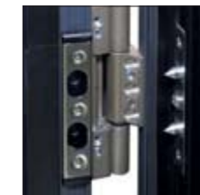
Doigt anti-soulèvement côté paumelles
