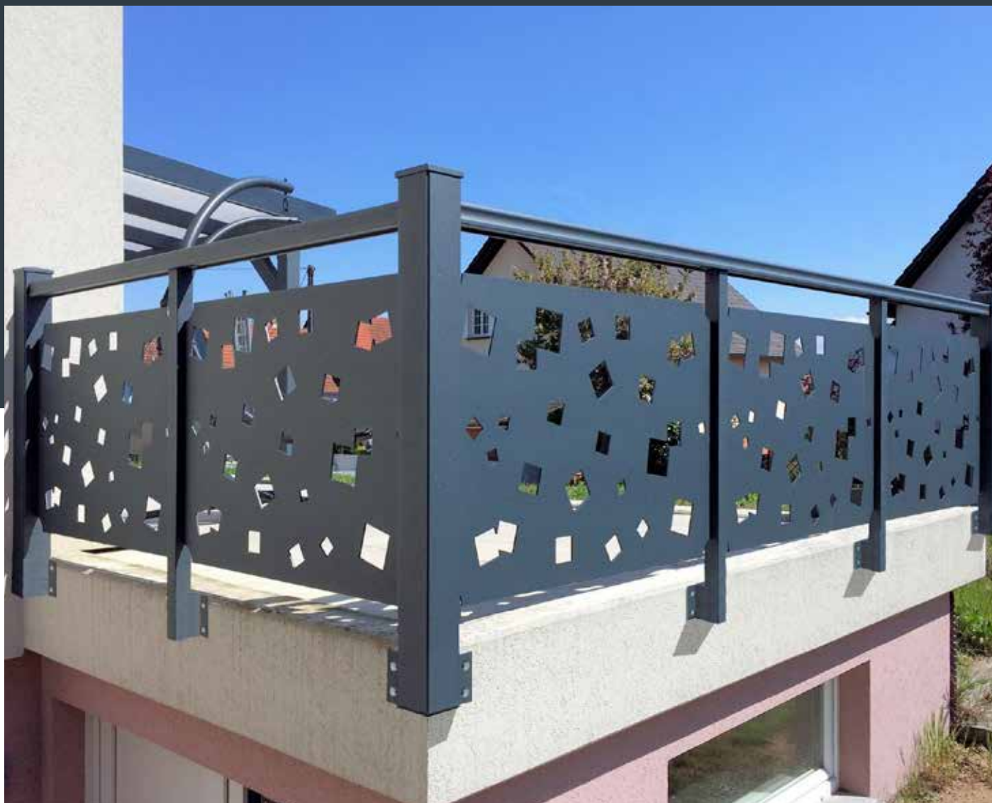
Pose en nez dalle + poteaux d'angle 100x100 mm
