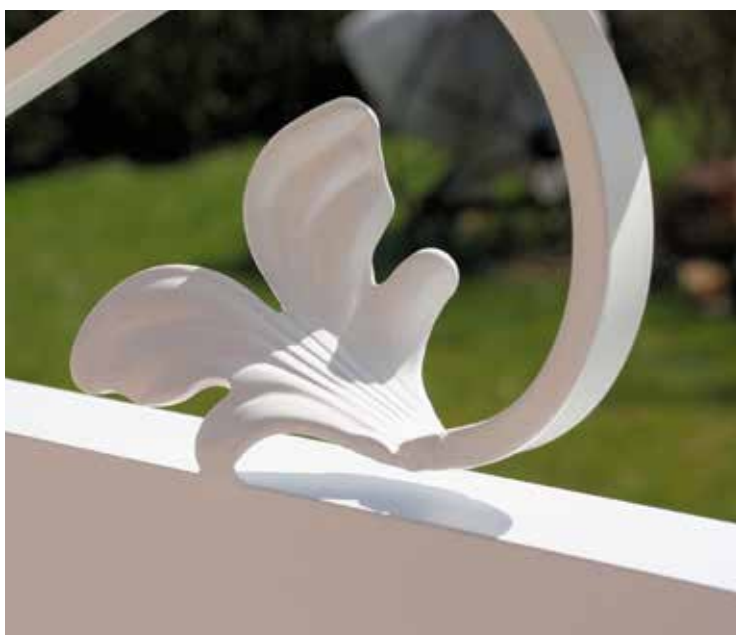
Détail volute feuilles avec point de soudure
