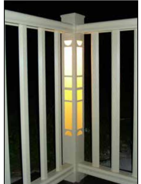
Eclairage dans poteaux
